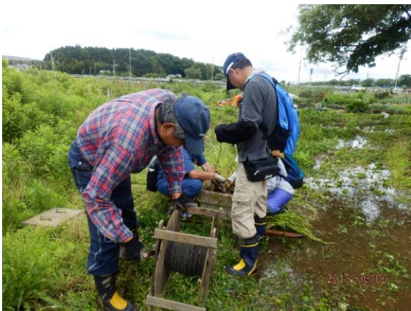
初めての暗渠清掃
